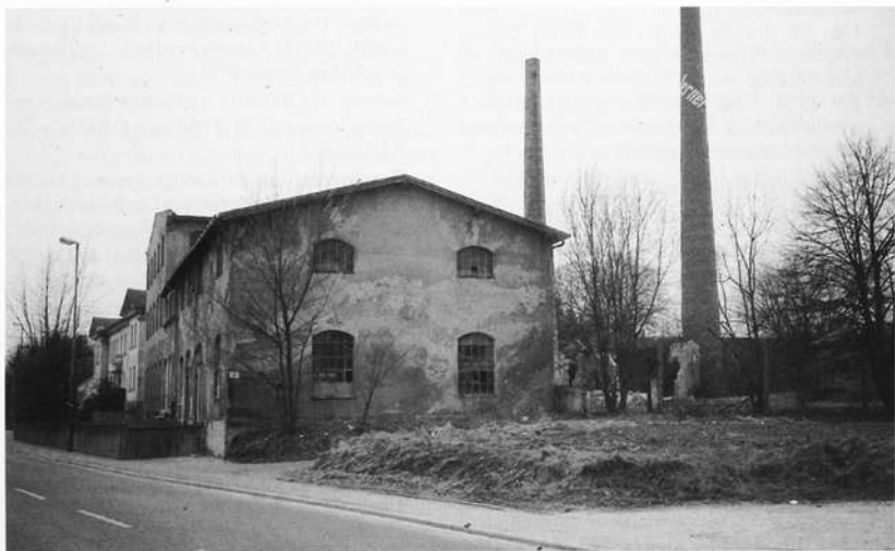
Produktionsgebäude der Porzellanfabrik Schney aus dem späten 19. Jahrhundert (Aufnahme 1990er Jahre, kurz vor dem Abbruch)
