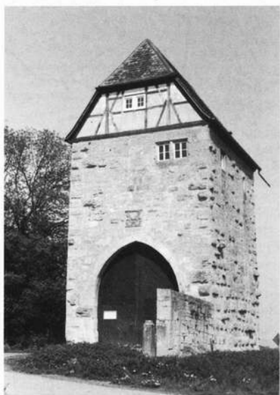
Durch den spätmittelalterlichen Landturm, hier von der Rückseite, zog früher der Verkehr der Landwehr. Foto: I. Rohloff
