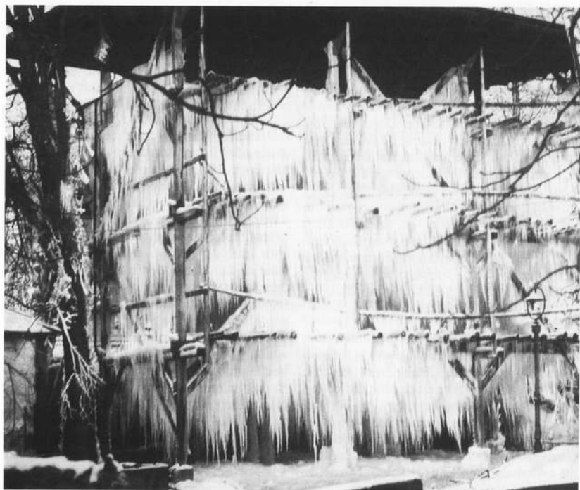
Abbildung 3: Zur Gewinnung von Eis verwendeten viele Bamberger Braustätten bis in die 1960-er Jahr hinein sogenannte „Eisgerüste“.
