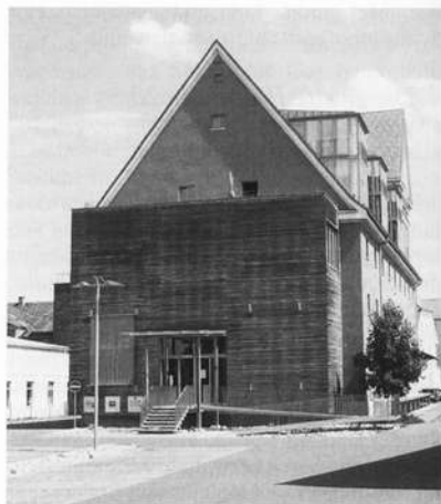
Abb. 4: Der umgestaltete BayWa-Speicher an der Lichtenhaidestraße
