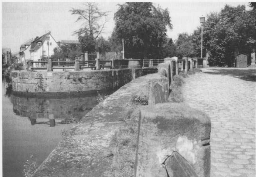
Abb. 10: Aufziehbrücke in Bamberg aufwärts von Schleuse 100
