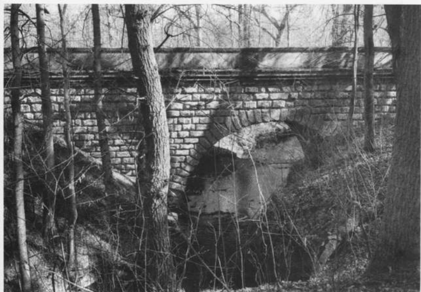
Abb. 3: Kanalbrücke („Brückkanal“) über den Gauchsbach östlich Röthenbach b. St. W.
