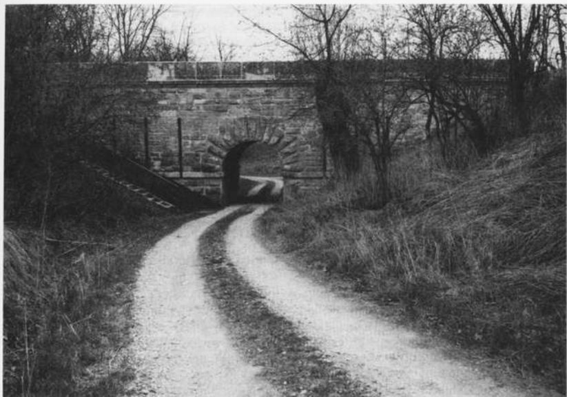
Abb. 4: Kanalbrückenartige Durchfahrt im Sulztal nördlich Beilngries
