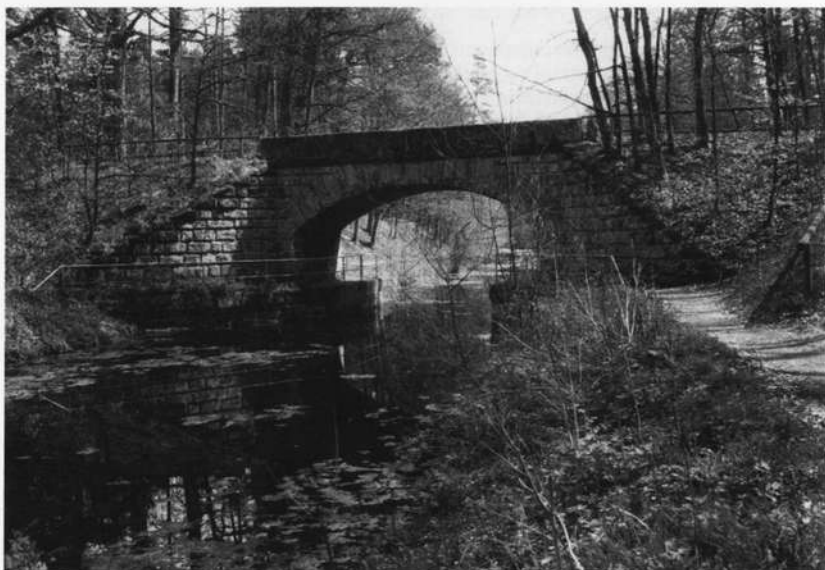
Abb. 5: Steingemauerte Flachbogenbrücke („Sorger Brücke“) westlich Wendelstein
