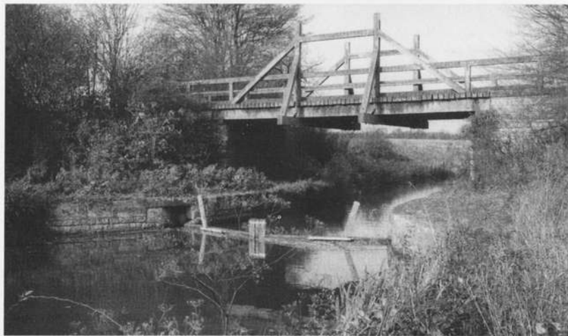
Abb. 8: Holzbrücke westlich Berg bei Neumarkt i. d. Opf.
