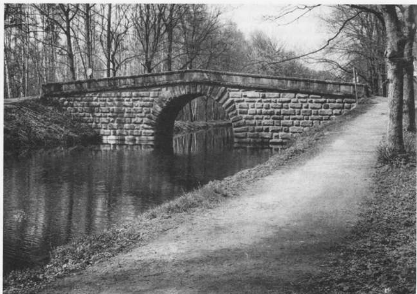
Abb. 6: Steingemauerte Rundbogenbrücke in Nürnberg-Gartenstadt/Falkenheim
