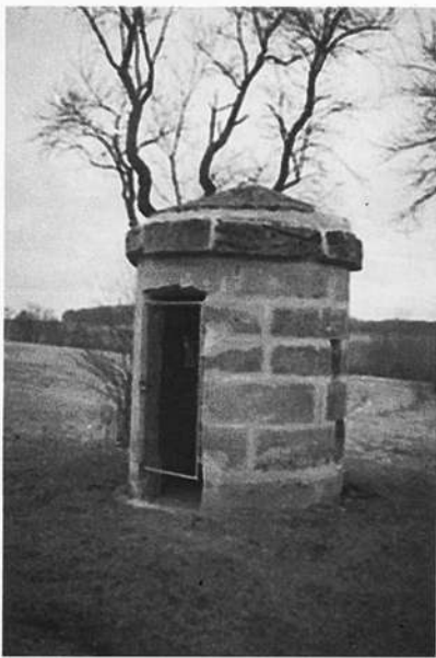
Das Feldhüterhäuschen nach seiner Versetzung. Im Original war das Bauwerk unverfugt. Beim Wiederaufbau wurde leider etwas zu viel Mörtel verwendet. Foto: H. Schatz
