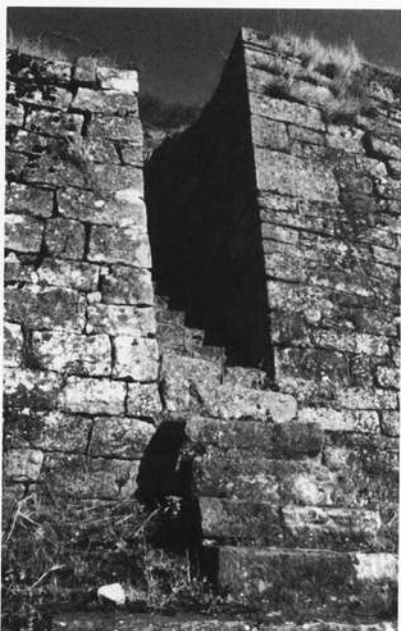
Hochaufragende Schildmauern mit eingetiefter Treppensteige. Foto: H. Haas
