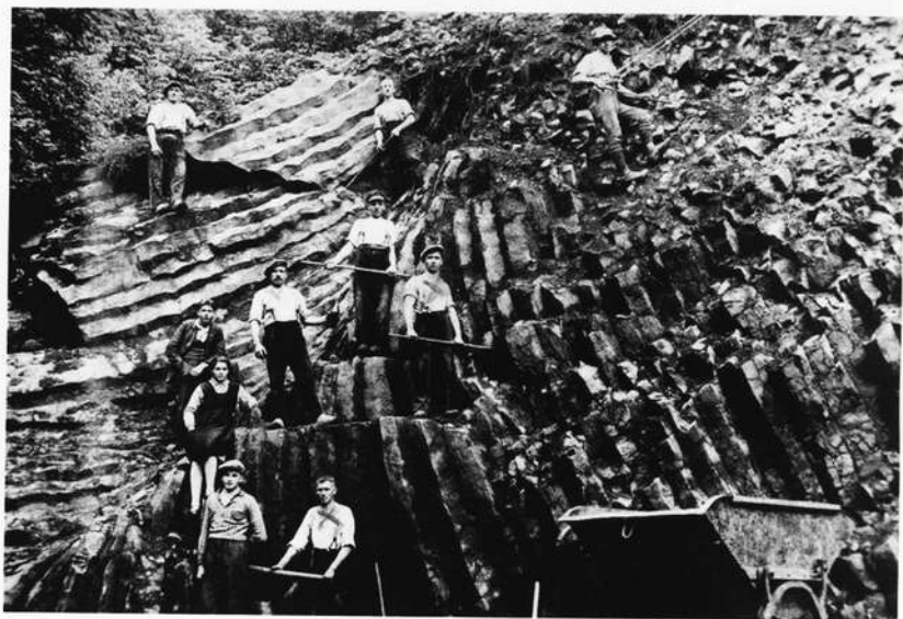
Die erste Mannschaft im Basaltwerk Stangenroth. Der Basalt wird mit Brecheisen abgebaut.
