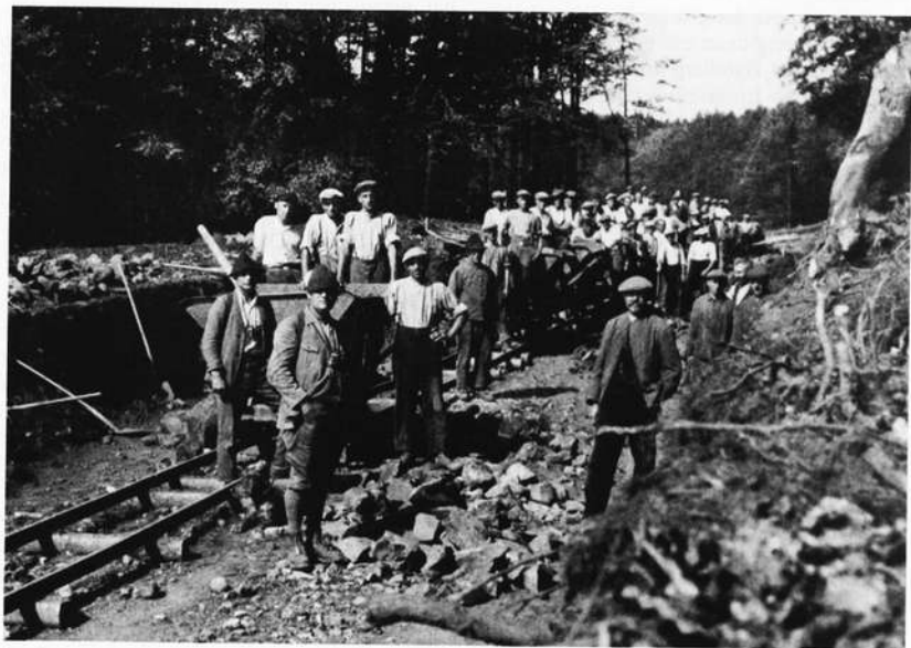
Straßenbau von Langenleiten zum Basaltwerk 1935. Im Vordergrund Rev. Forstwart Innozenz Kapp
