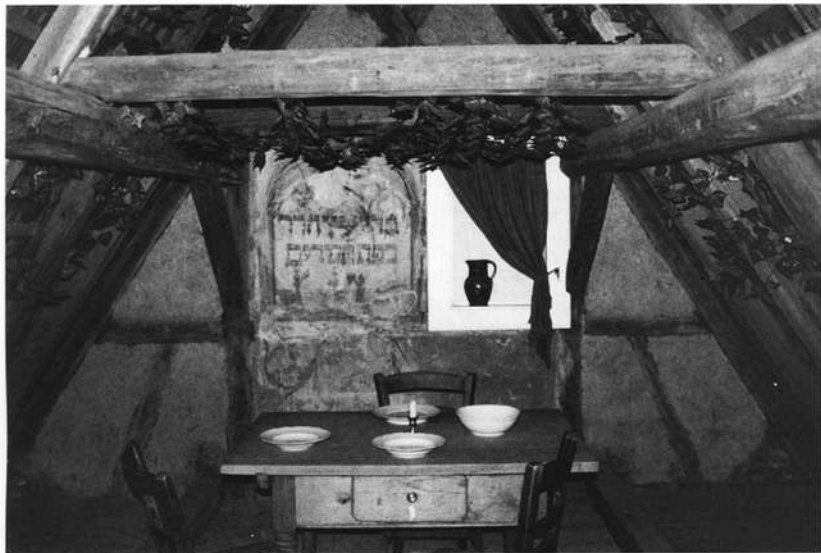
Freigelegte Fresken zum „Laubhüttenfest“
