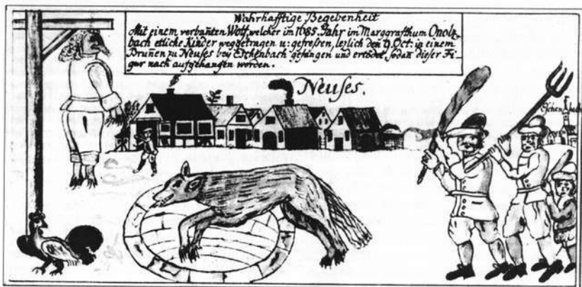
Spätere Zeichnung, wie die Bauern in Neuses bei Windsbach den Wolf im Brunnen erlegten.
