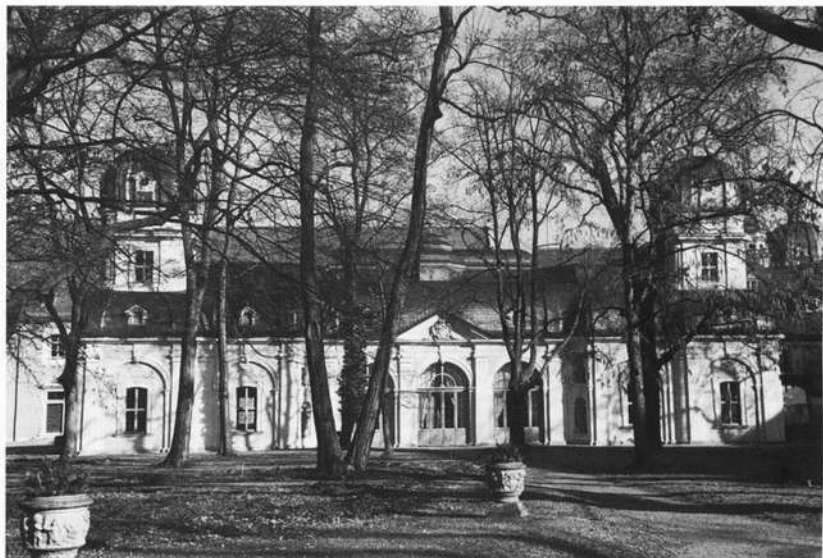
Der zu Beginn des 18. Jahrhunderts von Josef Greising für Fürstbischof Karl Philipp von Greiffenclau errichtete Gartenpavillon, der das Anatomische Institut beherbergte, erstrahlt nach der Renovierung in leuchtendem Gelb. Die „Alte Anatomie“ war der Wirkungsort so bekannter Männer wie Rudolf Virchow und Albert von Koelliker. Foto: Stiftung Juliusspital Würzburg
