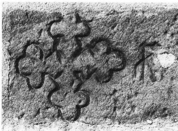
Abb. 2 Das gleicharmige nasenbesetzte Lilienkreuz außen in der Südseite der katholischen Stadtpfarrkirche von Lichtenfels, rechts ein Steinmetzzeichen. Die beiden Kreuzbalken sind 26 cm lang.
