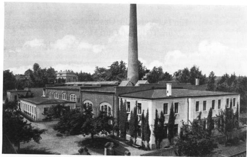
Inmitten der Gebäude im Pavillonstil steht das Maschinenhaus
