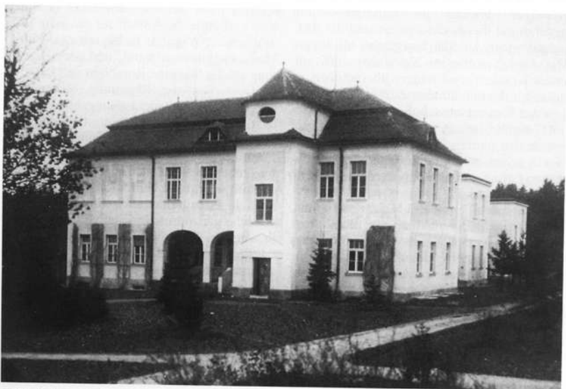
Gebäude für „Sieche Frauen“, nach Plan und unter Bauleitung von Kreisbaurat Josef Förster errichtet.
