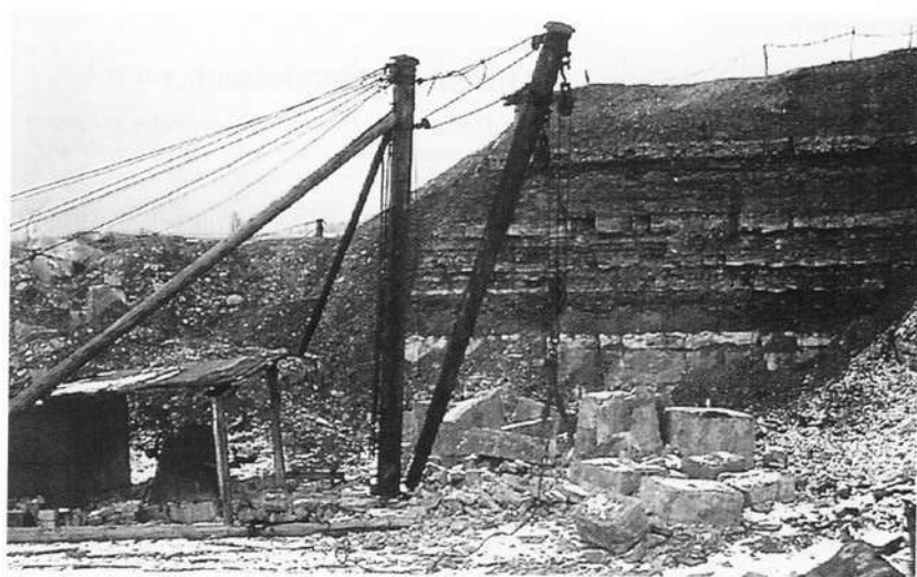
Derrick-Kran im Steinbruch auf dem Gersberg, Randersacker 50er Jahre
