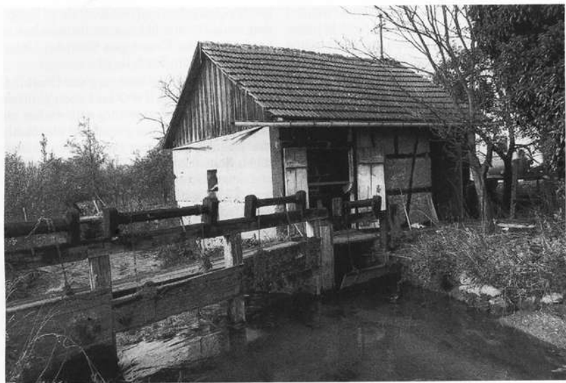
„Kraftwerk“ Müller in Lützelsdorf 1990 Wasserrad, Transmission und Stromerzeuger im Häuschen eingebaut
