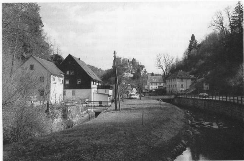
Elektrizitätswerk Eichenmüller 1995, seit 1906 Stromversorger von Pottenstein, frühere Getreidemühle mit Turbinenhaus, daneben 20 kV-Schaltstation mit Anschluß an das Überlandwerk Foto: Heller
