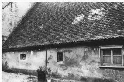
Abb. 9: Hs. Nr. 5, Rückseite. Massive Unterfangung und veränderte Befensterung. Links Stallteil erkennbar. Aufnahme Sept. 1998.
