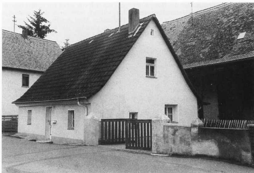
Abb. 11: Sambach, Hs. Nr. 52 (neu). Man beachte das auf dieser Aufnahme hinter dem Hoftor erscheinende kleine Erdgeschosfenster. Vgl. Abb. 9. Aufnahme Sept. 1998.
