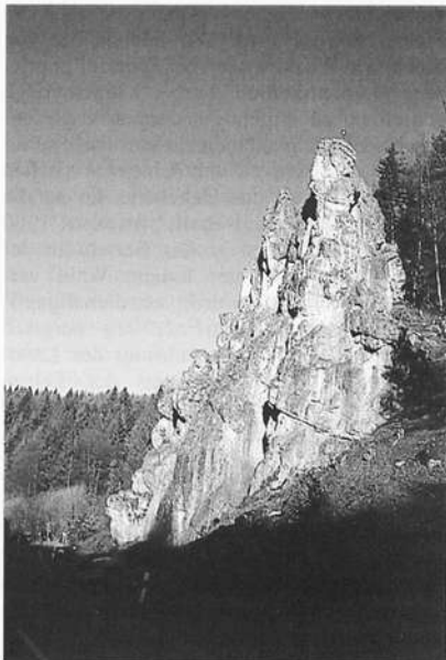
Hartelstein im Trubachtal nach Felsfreilegung Foto: Geißner
