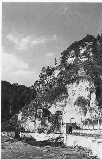
Felsenbord Pottenstein nach Freistellung des Sonnenhanges Foto: Geißner
