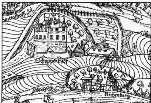
Abb.2: Schoppershof auf dem Rundprospekt der Stadt Nürnberg von Stefan Gansöder aus dem Jahr 1581. Deutlich ist der hochauftragende, ganz aus Stein erbaute Herrnsitz mit seinen charakteristischen Ecktürmchen zu erkennen, wie er nach seiner Zerstörung im Zweiten Markgrafenkrieg 1552/53 wiedererstanden ist. Das Bild belegt, daß das stattliche Renaissance-Schloßchen – entgegen anderslautender Behauptung in der Literatur – schon 1581 wiederaufgebaut war (Handschriftenabteilung der Stadtbibliothek Nürnberg, Will I. 26. M.).
