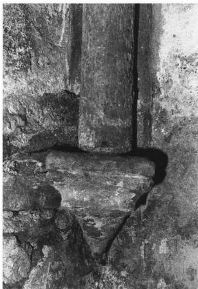
Abb. 8: Rippenkonsole in der Südostecke nach Freilegung.
