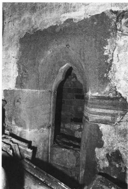
Abb. 11: Das südliche der beiden erhaltenen bauzeitlichen Spitzbogenfenster in der Westfassade.
