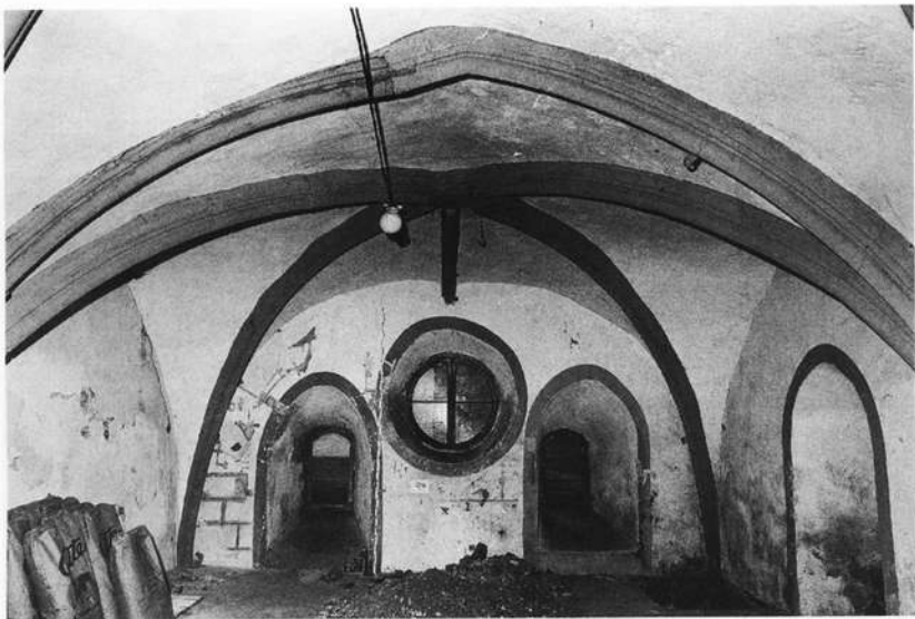
Abb. 12: Innenraum über dem Zwischengewölbe (Ebene 1); Blick auf die Ostwand.
