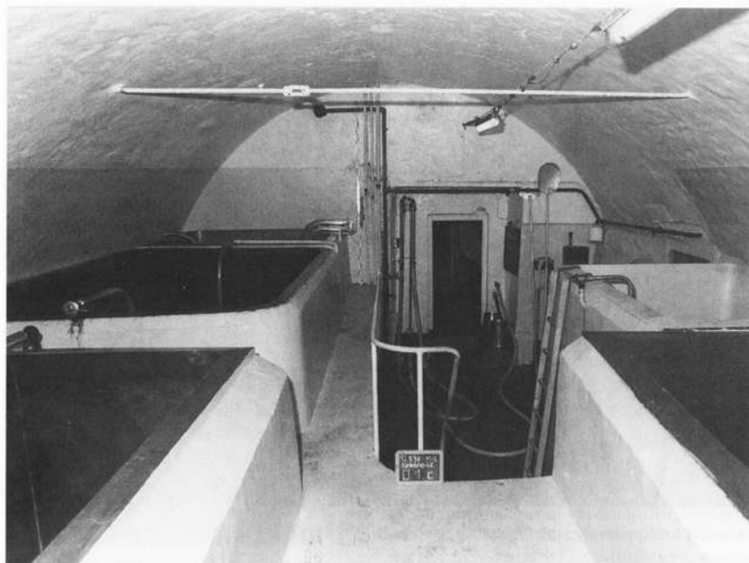
Abb. 13: Heutiger Gärkeller (Ebene 0) mit dem vermutlich 1878 eingebauten Zwischengewölbe; Blick nach Westen.
