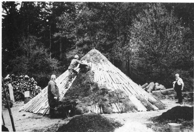
Abdeckung des Meilers mit Rasenplaggen; im Vordergrund: Haufen mit Kohlerde (Foto: Popp, 1995)
