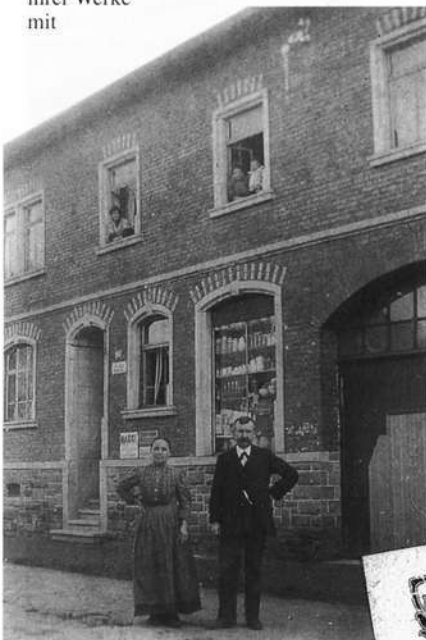
Adam Hugo errichtete im Jahr 1906 in Verlängerung der Hauptstraße von Hösbach ein Wohn- und Geschäftshaus, in dem er einen Kolonialwarenhandel betrieb.
