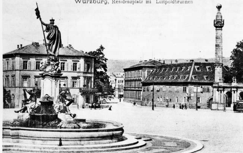
Würzburg, Residenzplatz mit Luitpoldbrunnen
