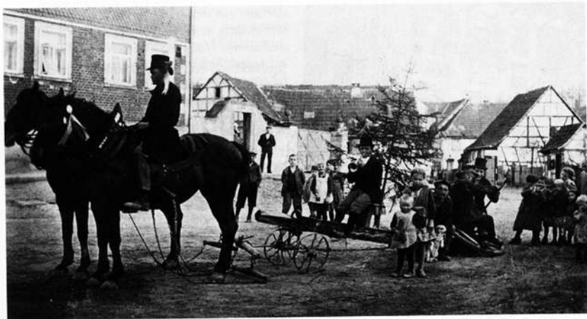
Dem Richtfest voraus ging ein Spektakel, um die gesamte Dorfbevölkerung auf das Ereignis aufmerksam zu machen.
