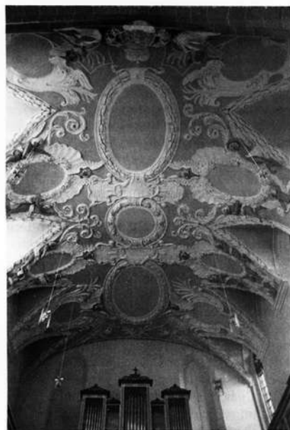
Abb. 2 Ehemalige Stiftskirche Himmelkron: (Decke)
