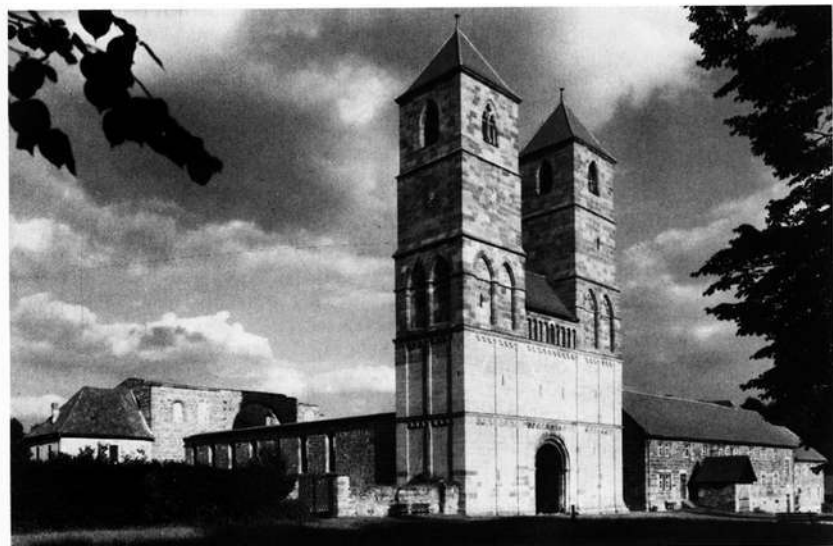
Veßra – das ehemalige hennebergische Hauskloster: Ruine der Kirche St. Marien mit Westbau und Klausur.
