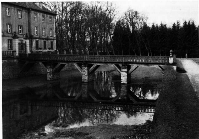
Die Brücke über den Schloßgraben
