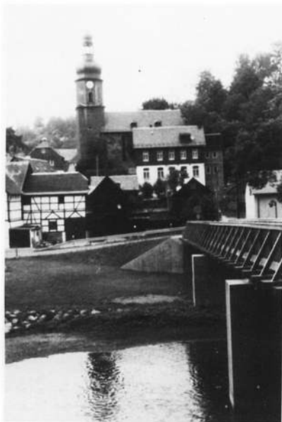
Die Kirche von Sparnberg, vom westdeutschen Saaleufer aus gesehen, samt der neuen Brücke; früher gab es eine berühmte überdachte Brücke über das Fließchen. (Fotos: H. Meißner)
