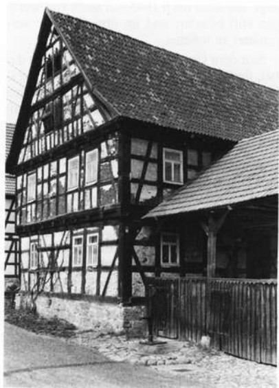
Fachwerkhaus in Heldburg / Kreis Hildburghausen
