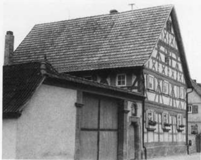
Bild 2: Diese Toranlage in Saal, Lkr. Rhön/Grabfeld, auf 1822 datiert, verdeutlicht mit ihrer Geschlossen- heit in die inneren Motive der Hoftoresetzung: Schutzbestreben, Besitzerstolz, Frömmigkeit
