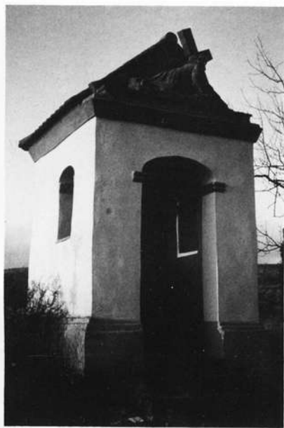
Bild 5: Karlstadt, Wegkapelle von 1737 an der Eußenheimer Steige, renoviert 1989
