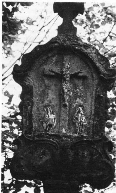
Bild 4: Binsfeld, Bildstock von 1759 an der "Alten Kirche": Schäden durch Armierung unter Minerosantrag (Renovierung um 1965)
