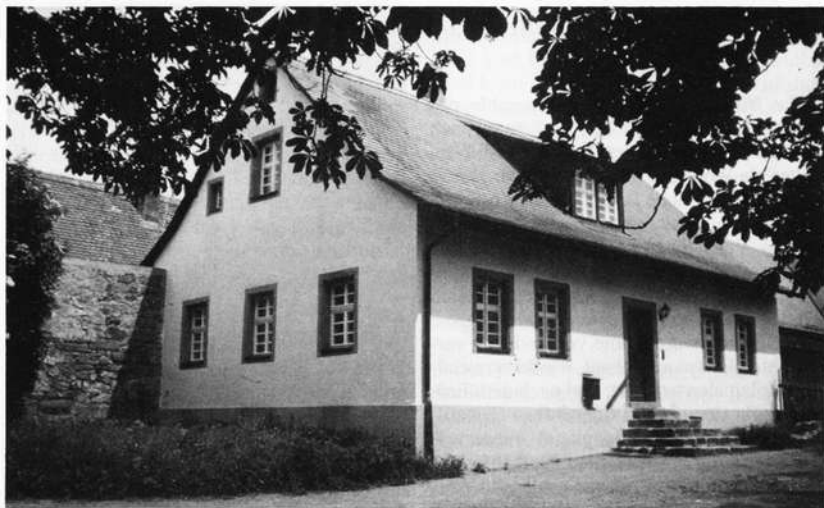
West- und Südansicht nach Sanierungsabschluß
