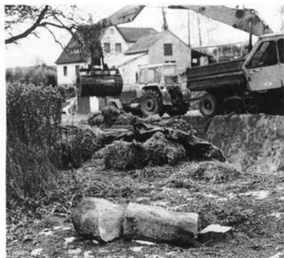
Die Welchendorfer Docke nach der Zerstörung durch LPG-Fahrzeuge im Dezember 1989. Die Grundplatte der Docke ist bereits im aufgeschütteten Erdreich verschwunden Foto: Klaus Dietrich Zeuschel
