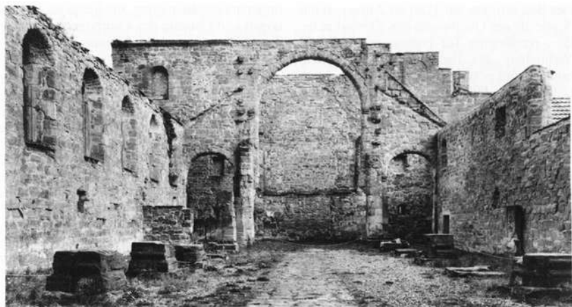
Blick in Lang- und Querhaus (vor Beginn der Sanierungs- und Rekonstruktionsarbeiten)
