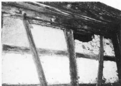
(Bild 3 und 4) Der obere Teil des Gefaches neigt sich nach innen. Das Gefach rechts davon war schon teilweise eingebrochen (September 1990)
