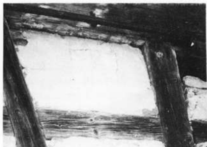
(Bild 3 und 4) Der obere Teil des Gefaches neigt sich nach innen. Das Gefach rechts davon war schon teilweise eingebrochen (September 1990)
