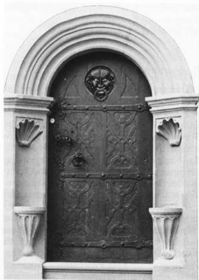
Das original erhaltene Portal zum Treppenturm ("Schrotturnm") des Patrizierhauses
