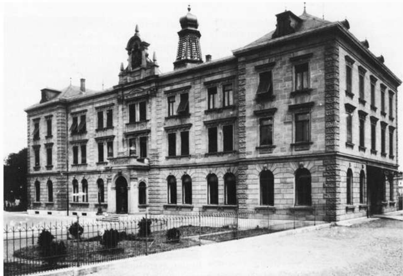
In einer Aufnahme aus dem Jahr 1913 sehen wir hier das 1902 durch die Gebrüder Wörlein erbaute und am 23. 2. 1945 zerbombte Ansbacher Postamt.
