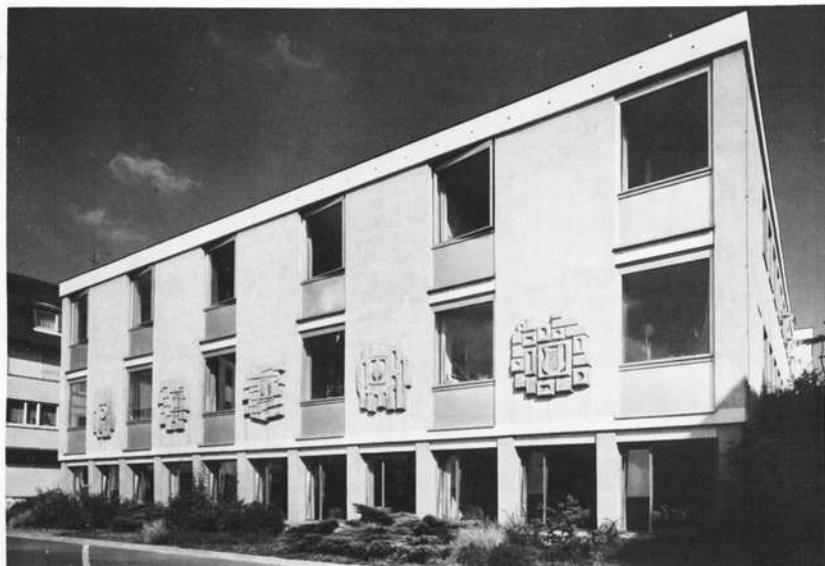
Friedrich-Rückert-Bau, seit 1962 Heimstätte von Stadtarchiv und -bibliothek Schweinfurt
