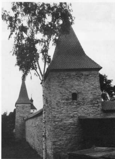
Die Gredinger Stadtmauer nach dem Abschluß der Sanierung
