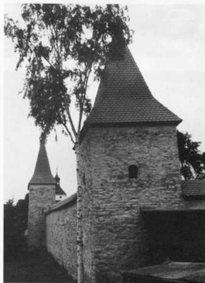
Die Gredinger Stadtmauer nach dem Abschluß der Sanierung
