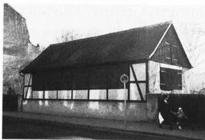
Die alte Gerberscheune Glossner in der Schalkhäuser Straße in Ansbach in einer Aufnahme aus dem Jahre 1990
