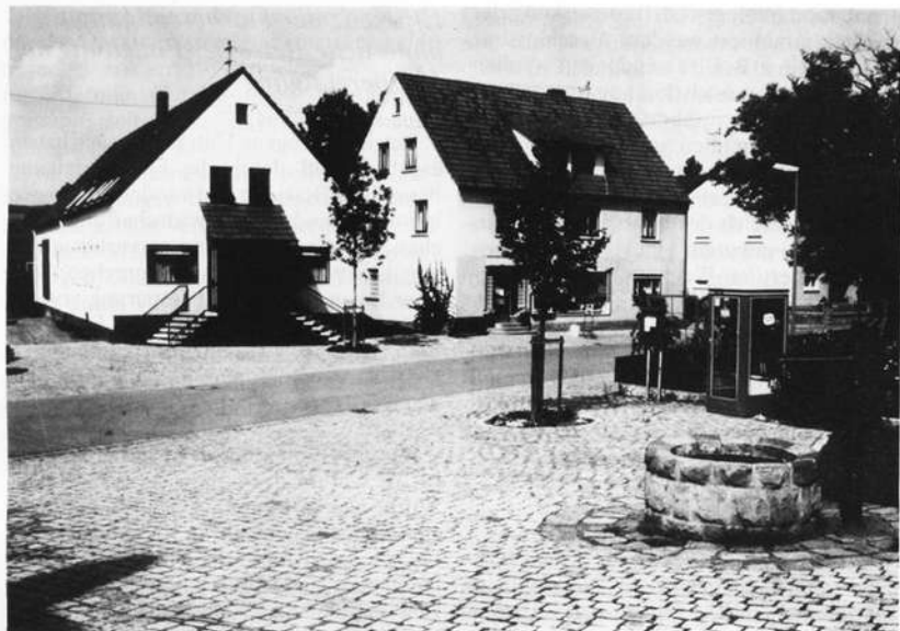
Durch den Abbruch eines leerstehenden Zweckgebäudes, Gebäudesanierungen, Errichtung eines Brunnens, Pflanzung von 4 Laubbäumen und Aufstellung von Ruhebänken ist ein Dorfplatz entstanden – heute Kommunikationsmittelpunkt von Hutschdorf und Festplatz für Dorffeste.
