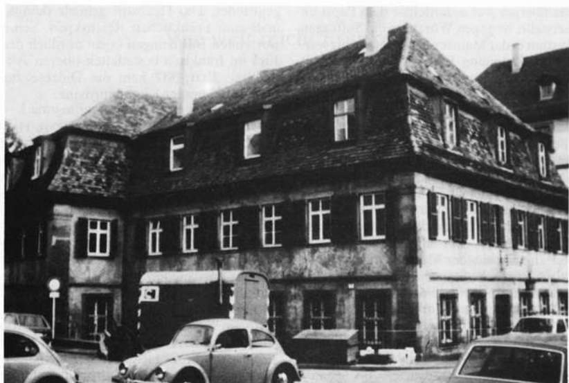
Die Brudermühle vor der Sanierung.
