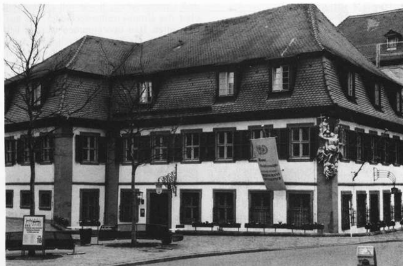
Die Brudermühle in Bamberg nach der Sanierung und Revitalisierung.
