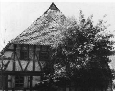
Wohnstallhaus Unterefelden Nr. 9 – Giebelseite – 1986
