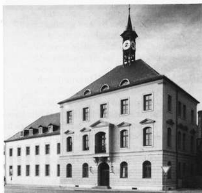
Aufnahme nach dem Umbau
