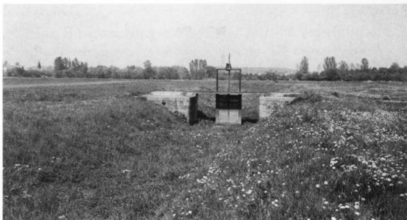
Stauschleuse mit Schützenbrettern im Hauptzuleiter (Frühjahr 1987).
