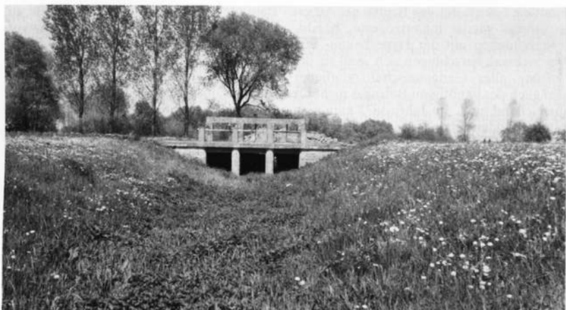
Einlaßschleuse und Hauptzuleiter rechts der Itz (Frühjahr 1987).
