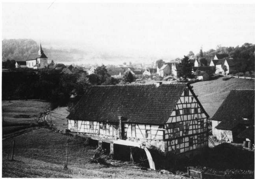
Oberweißbrunn, Blick auf die Mühle an der jungen Brend und das Dorf. Das Oberschechtige Mühlrad ist in Betrieb. Heute stehen Kirche und Mühle nicht mehr. (Originaltitel: "Oberweißbrunn")
