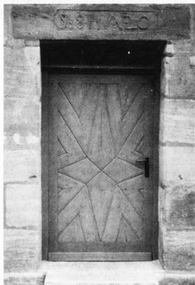
Nach der Restaurierung
