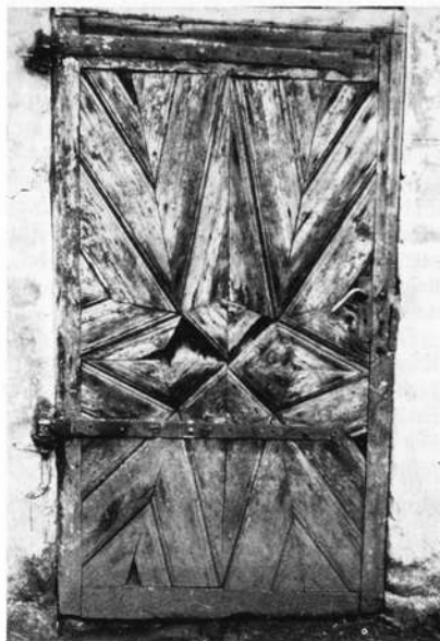
Vor der Restaurierung
